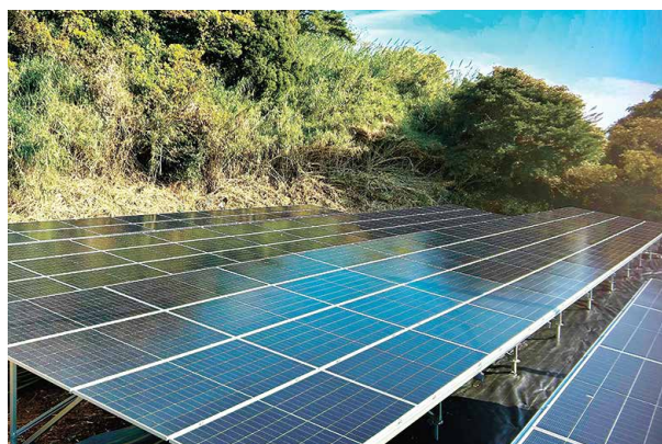
諫早市の工場へ電力供給する太陽光発電所の建設現場
